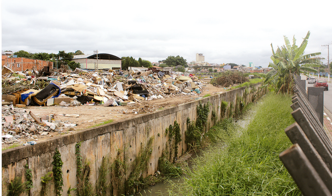
Entulhos próximos ao piscinão e ao córrego Ribeirão Itaim que corta o centro de Poá
